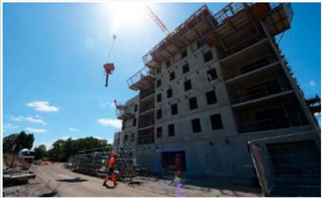
Chantier de La Maillerie, à Villeneuve-d'Ascq
