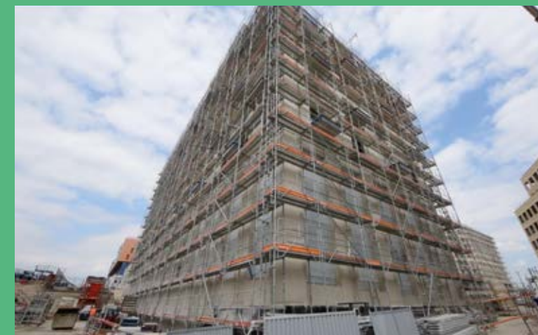
Chantier Îlot Fertile, à Paris, 19 e arr.
