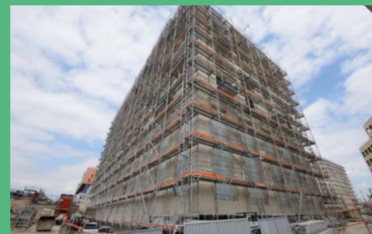
Chantier Îlot Fertile, à Paris, 19 e arr.
